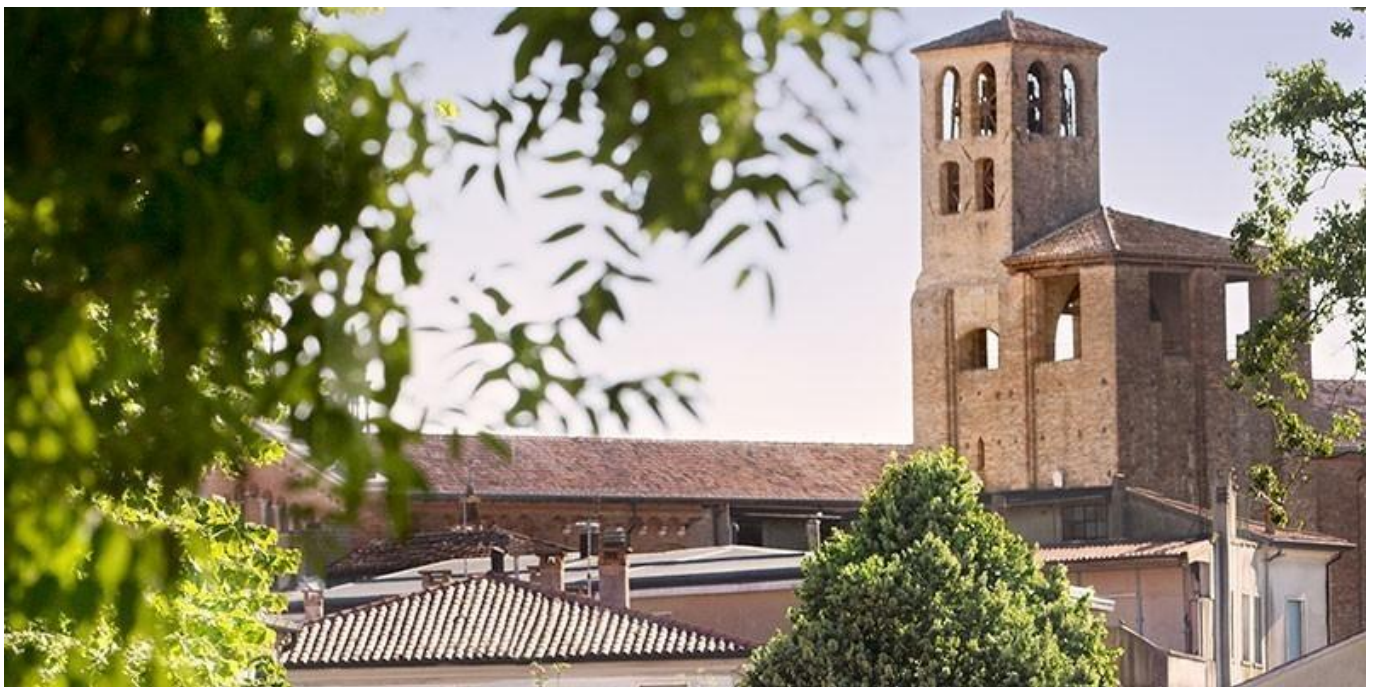
La Torre Carrarese, sentinella di S. Martino
